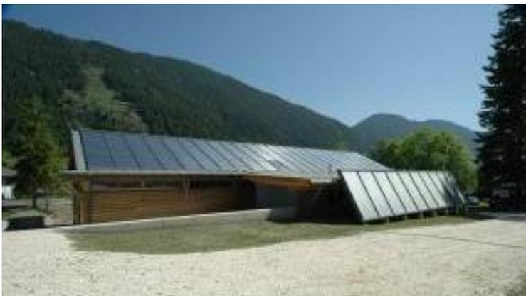
Abbildung 16: Sanitärgebäude „Camping Knaller“; südliche Dach Dachfläche mit thermischen Kollektoren bestückt, Warm-Wasserspeicher deckt 100 % des Brauchwassers ab.
