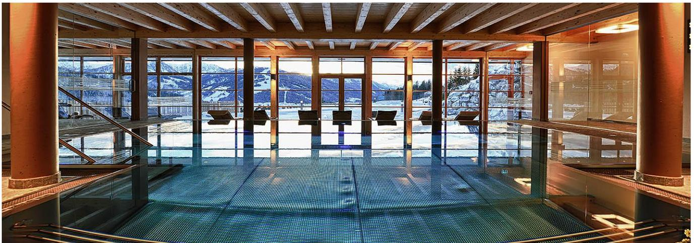
Abbildung 50: Flachdach in Holzbauweise beim Passivhausschwimmbad „Hotel Edelweiss“, Fam. Bergmüller in Wagrain. Die gesamte Primärholzkonstruktion sowie sämtliche Deckenbalken bleiben im Raum sichtbar. Die doppelte Dampfbremse befindet sich oberhalb der Sichtschalung bzw. oberhalb der Holzakustikdecke.
