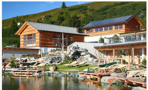
Abbildung 15: Erweiterung „Mountain Resort Feuerberg“, Gerlitz; dachintegrierte thermische Solarkollektoren zur Erwärmung des Badeteiches.
