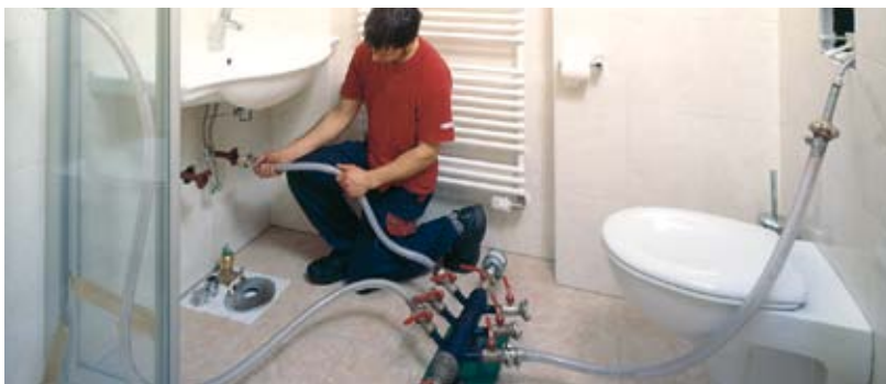
Rohrsanierung von innen
