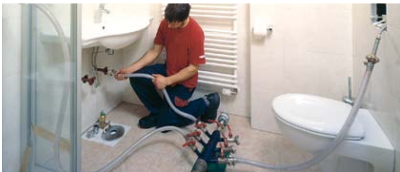
Rohrsanierung von innen
