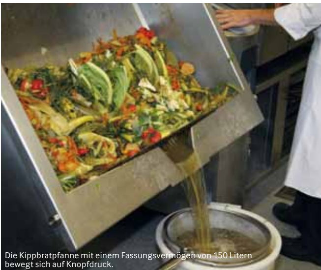
Die exakt geplante Hotelküche im Hoschober ermöglicht professionelles Arbeiten auf höchstem Level.
